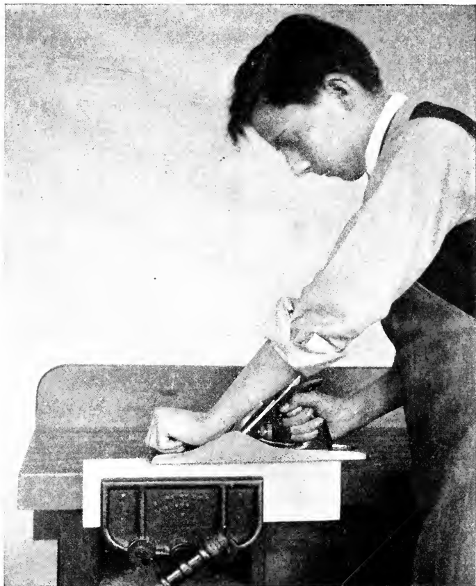
Fig. 76—Jointing Edge in Vise
